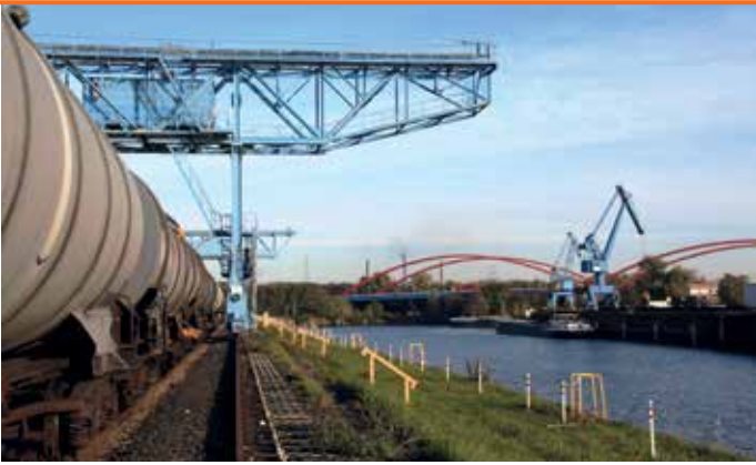
Die trimodale Anbindung des Hafens ist bei vielen Unternehmen gefragt | Bilder: Hafen Essen
