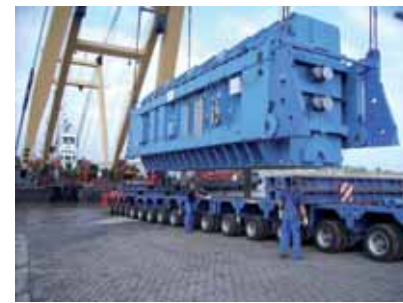
Umschlag des Transformators auf 19-Achs-Plateauwagen mittels Schwimmkran
