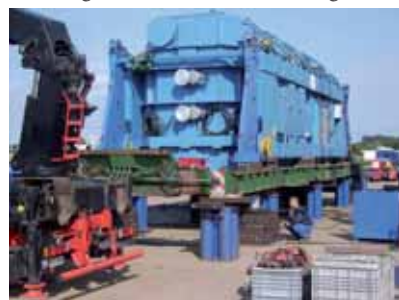
Absetzen des ersten Transformators an der Umschlagstelle inklusive Handling des Lastverteilerrahmens
