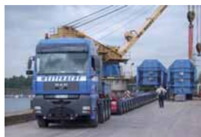
Absetzen des 2. Transformators unmittelbar vor der Positionierung der Autokrane für den geplanten Tridem-Hub
