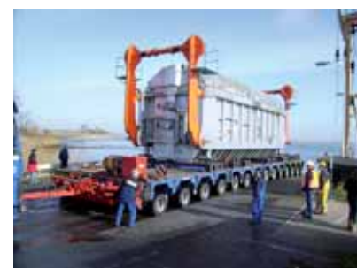
Abtransport des 1. Alttrafos mit 1,5-fach breit gekoppeltem Transportfahrzeug
